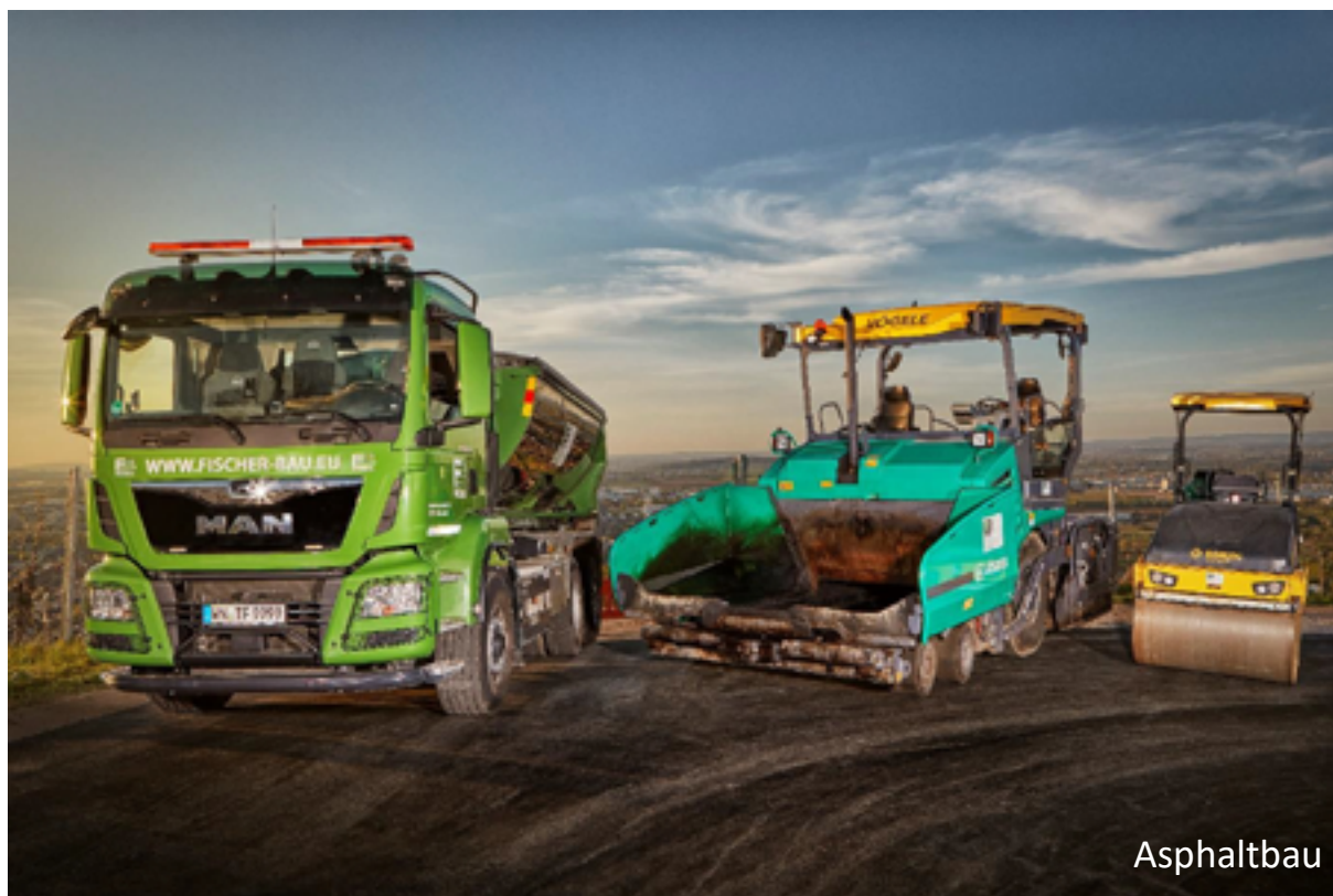
Tief- und Straßenbau
